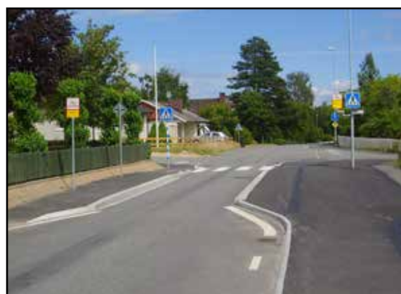
Figur 3.1.3. Exempel på timglashållplats.
