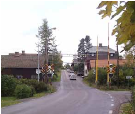
Figur 5.2.13. Befintlig vägmålning, väg 656 i Sellnäs.
