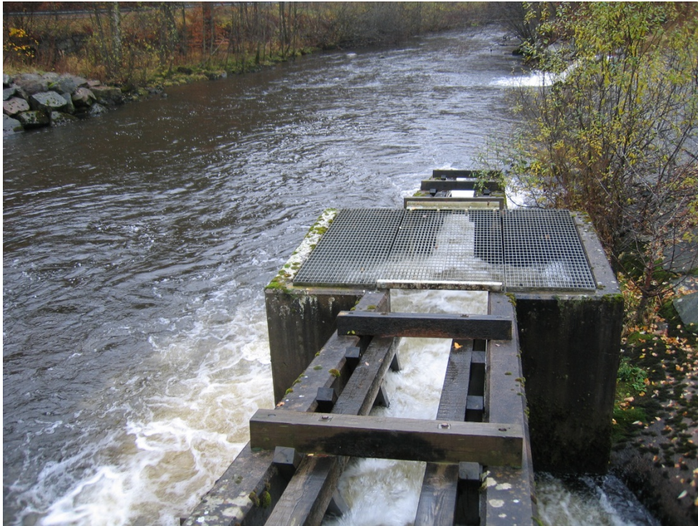
Bild 1. Jonsereds övre fiskväg, en denilränna, erbjuder fisken en vandringsväg förbi dammen som utgör ett definitivt vandringshinder mellan naturfåran vid Jonsereds kraftverk och sjön Aspen. I fiskvägen finns sedan 2005 en automatisk fiskräknare installerad. Foto: Länsstyrelsen i Västra Götaland.
