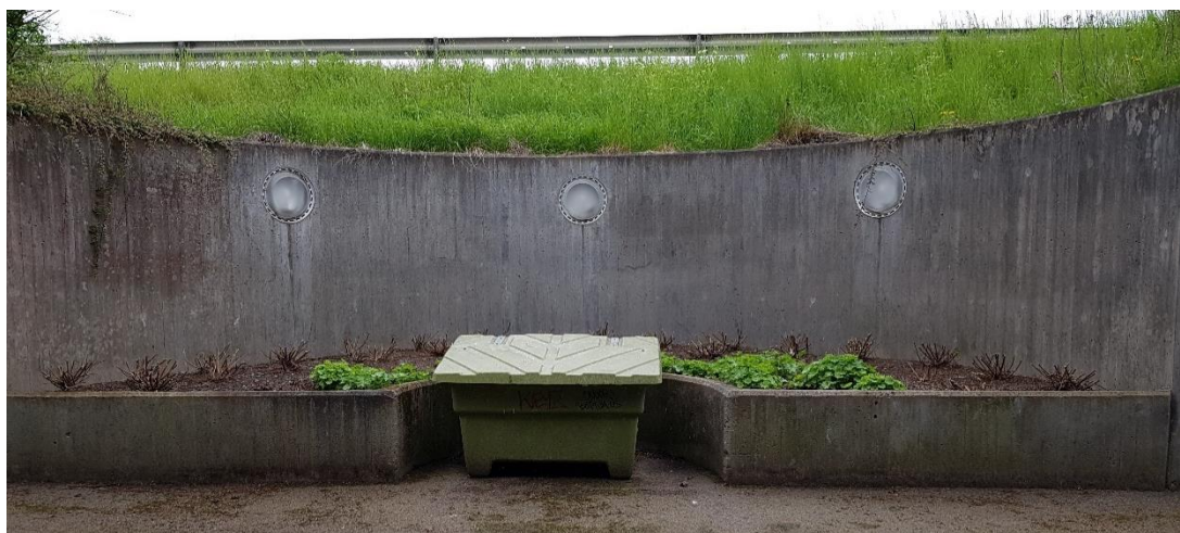
Figur 9. Platsen norr om befintlig port där den nya porten är tänkt att anläggas.
