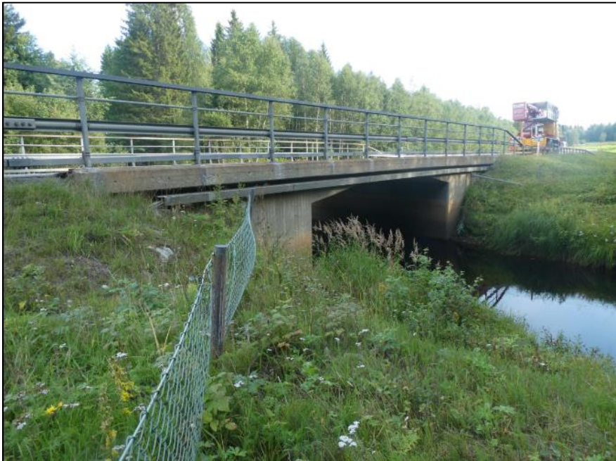
Figur 2-1. Mångbyåns passage under E4 (uppströms).
