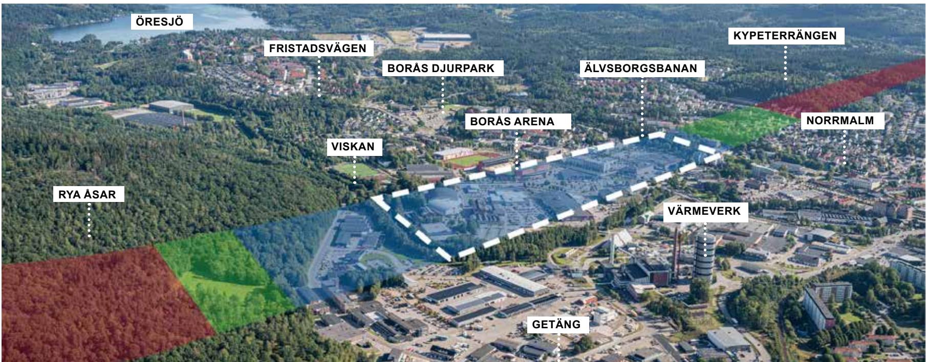
Figur 8.46 Vy från sydväst. Flygfoto över korridorens utbredning i station B2.
