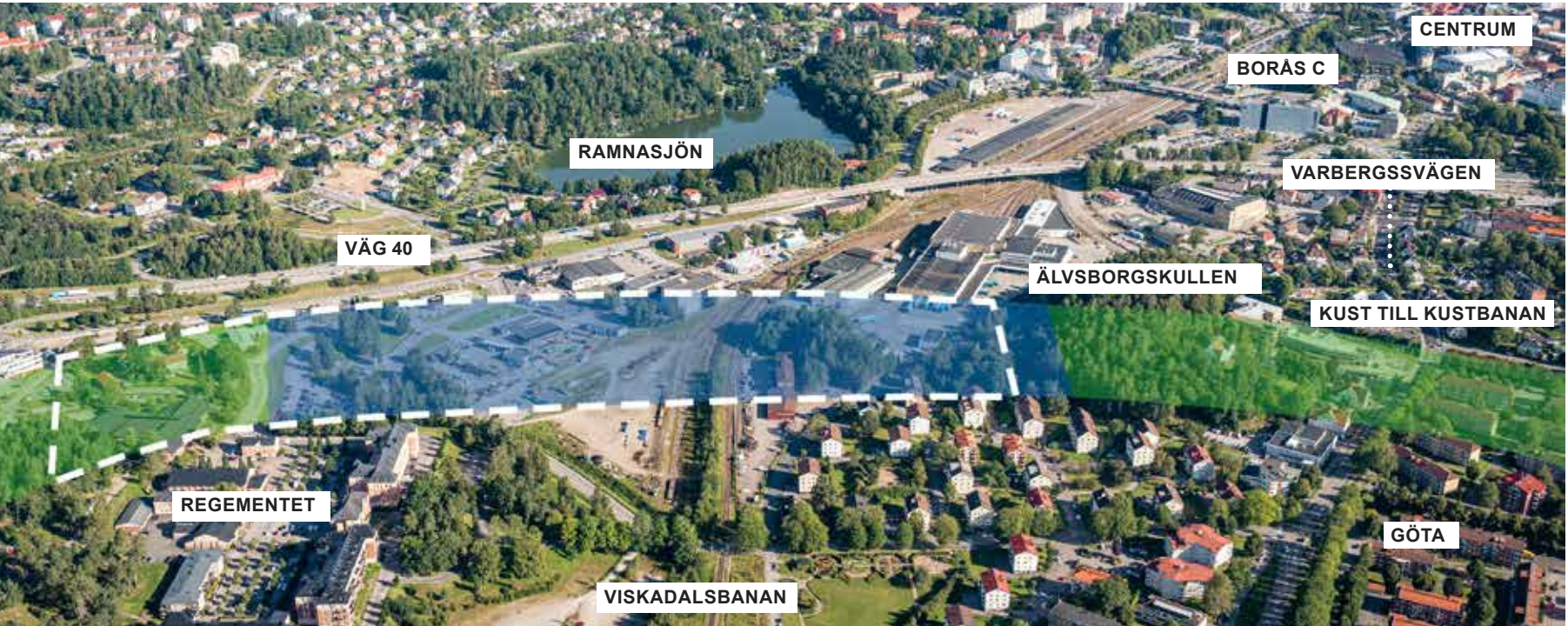
Figur 8.49 Vy från söder. Flygfoto över korridorens utbredning vid station B4.
