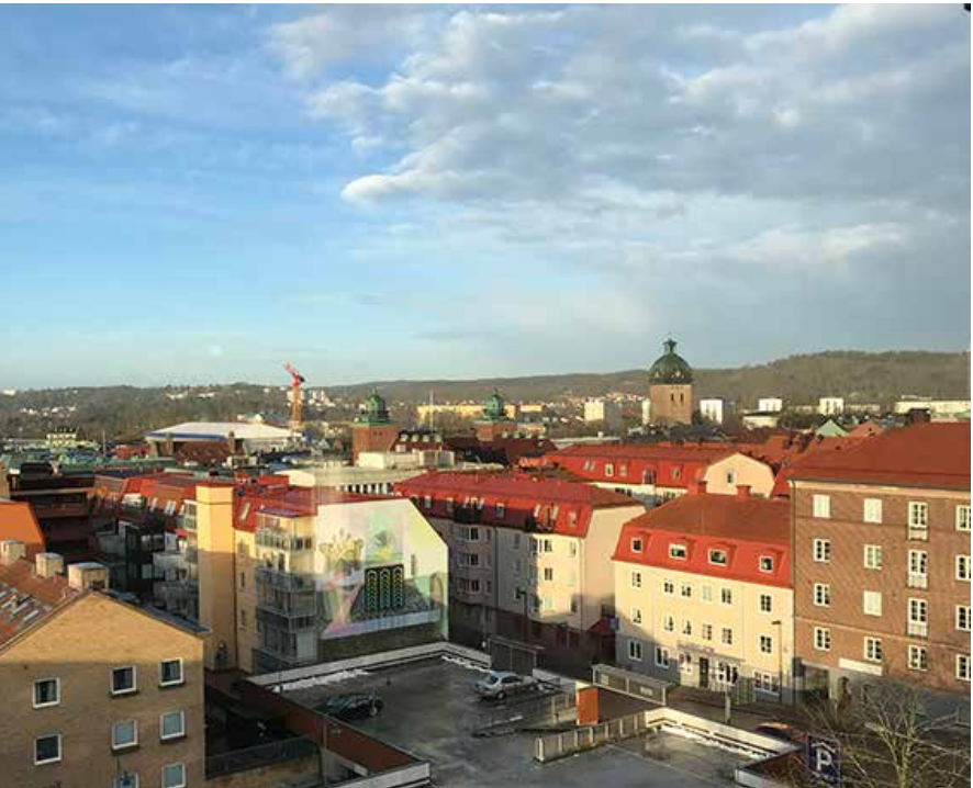
Figur 4.21 Del av Borås centrum med Ryas åsar i fonden.
