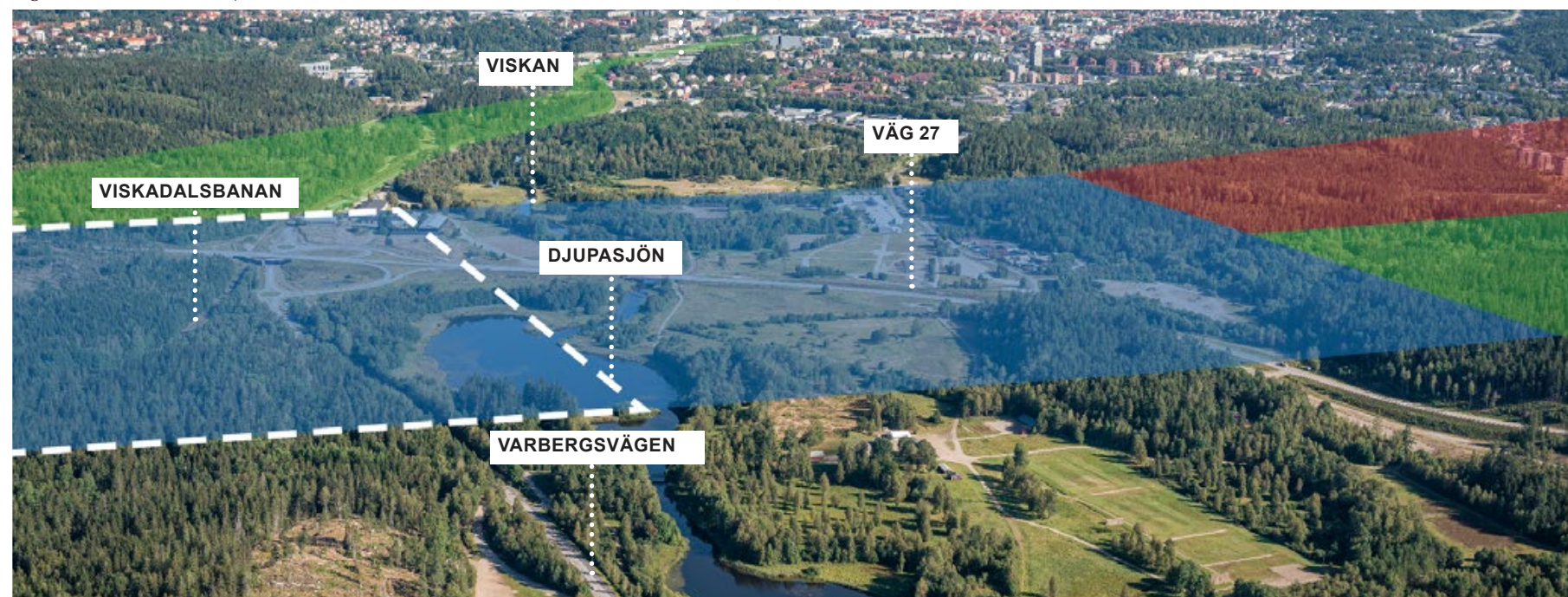
Figur 6.51 Vy från söder. Flygfoto över korridor Osdal/Borås C med station B11A.
