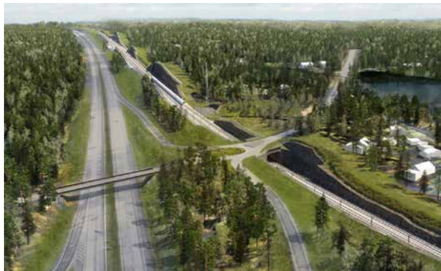
Figur 36. Illustrationsexempel på hur en samförläggning med väg 27/40 och den nya stambanan kan se ut. Området mellan vägen och järnvägen skulle kunna vara aktuellt att landskapsmodellera. Illustrationen kommer från Gestaltungsprogrammet för den tidigare utredningen för sträckan Mölnlycke-Bollebygd. (Illustration: Sweco, Trafikverket, 2015)
