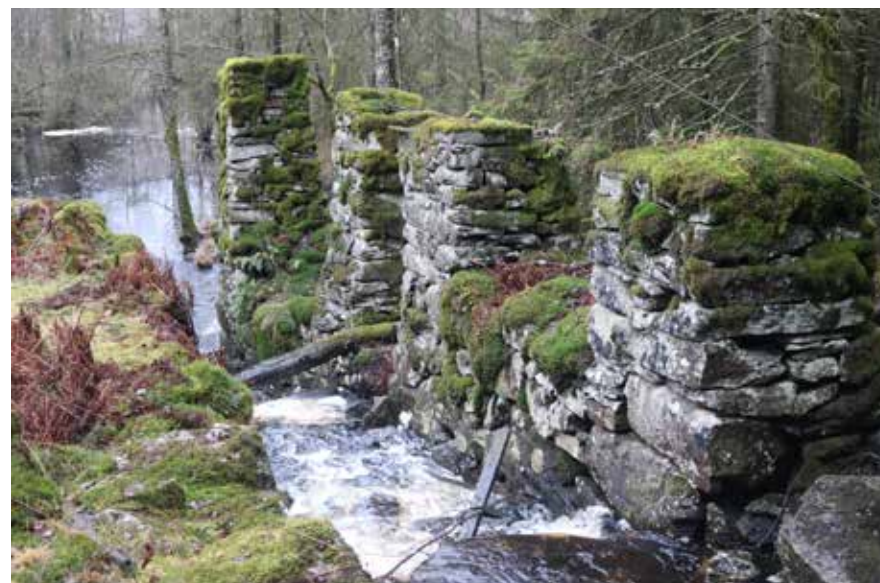
Figur 5.17 Lämningar efter Katrinefors kopparhammare. Foto: KMV forum.
