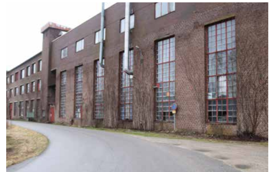
Figur 5.18 Industribyggnader vid Rydboholms fabriker. Foto: KMV forum.
