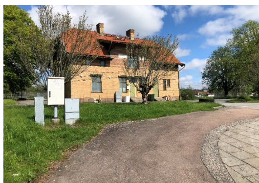
Figur 10. Säve Stationshus med tillhörande parkmiljö och hamlad allé i nära anslutning till stationshuset.
