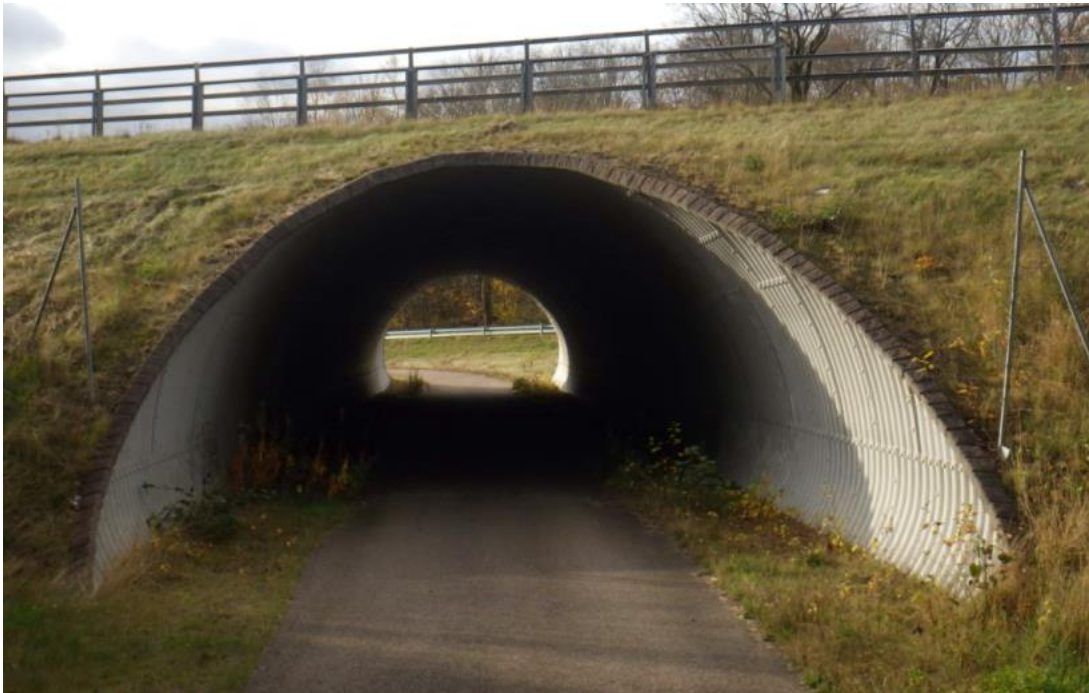
Figur 19 Bro över GC-väg S tpl Saltkällan 14-1684-1 (Rörbro)
