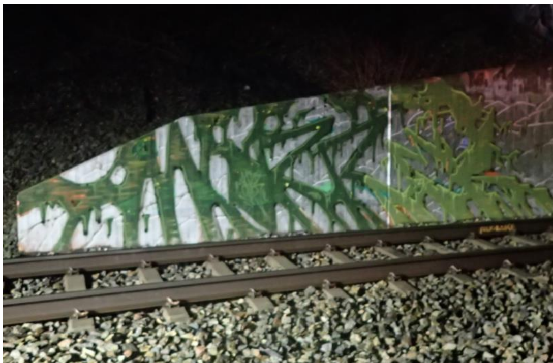
Figur 21 Betongstödmur Kyrktorpstunneln 6, 3520-115-4 (L-stöd)
