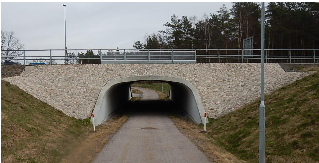
Figur 20 Bro över GC-väg SO Vanneberga vid Rosenlund på rv 21 11-1006-1 (Valvbro)
