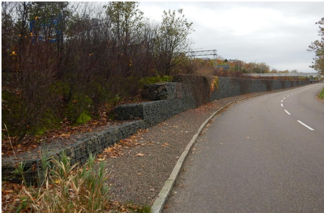
Figur 22 Gabionmur Lergökgatan-Radiovägen, 1480-4449-1 (gabionmur)
