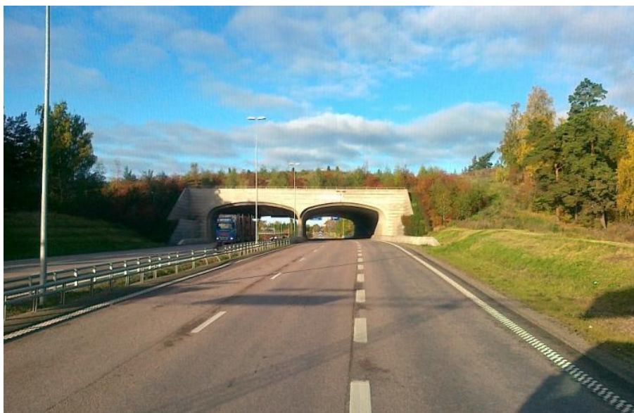
Figur 2. Exempel på ekodukt, denna öv er Bärbyleden i Uppsala (foto från BatMan).
