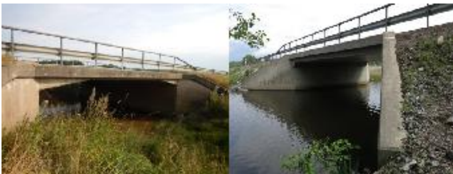
Figur 10. Vägbro 19-187-1 (till vänster) och vägbro 19-503-1 (till höger). Foton från BaTMan.
