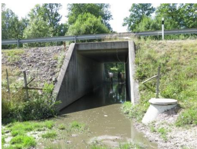
Figur 9. Vägport 19-1016-1. Foto från BaTMan.
