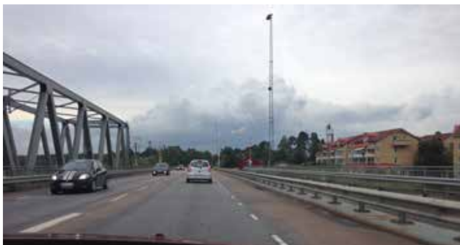
Figur 36. Bron över Kvicksund, byggd 1976. Från söder.
