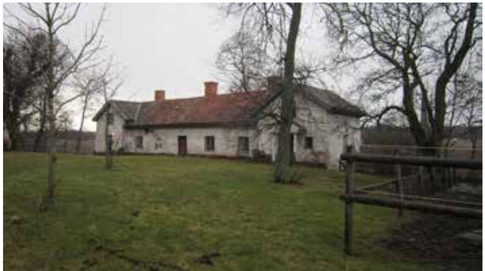
Figur 70. Statarbostad strax intill Stora Ekebys huvudbyggnad (1800-1900-tal).
