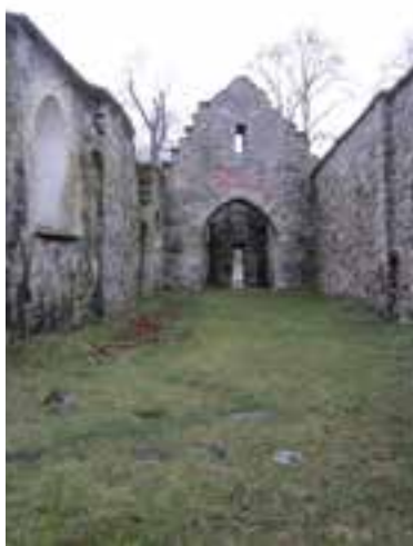
Figur 23. Ruiner efter Stora Rytterne kyrka. Ursprungligen från 1100-talet, murverket är restaurerat på 2000-talet.
