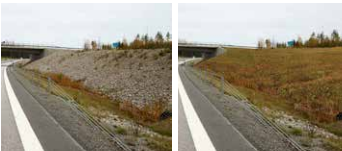
Ovan: Exempelbild t v visar krossslänt i anslutning till vägen som ger ett ovårdat, rått intryck i miljön. Exempelbild t h visar samma slänt som är besådd med gräs och bättre ansluter till omgivande landskap
