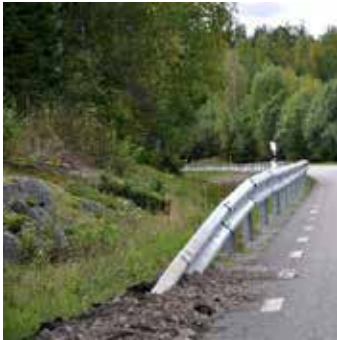
Exempel på balkräcke W-profil. (Källa ATA)
