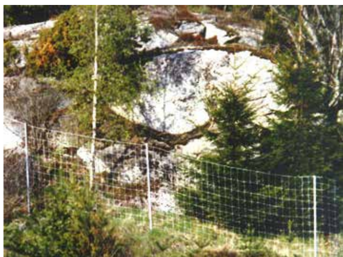
Exempelbild på bra placering av viltstängsel, infogat i terrängen mellan vegetationen och som följer topografin. Källa: Vägen, en bok om vägarkitektur
