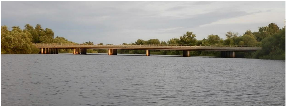
Figur 2. Broarna över Helge å, vy mot söder. Källa BaTMan, Trafikverket (2015).
