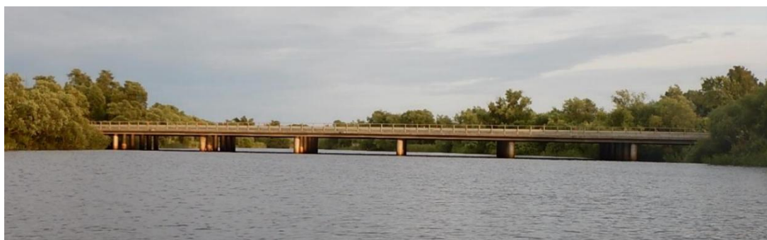
Figur 2. Broarna över Helge å, vy mot söder. Källa BaTMan, Trafikverket (2015).
