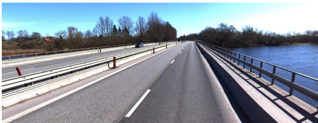
Figur 4. Broar över Helge å, avbildade mot öster. Avspärningar finns längs broarnas sidor för att förhindra belastning av dessa delar.
