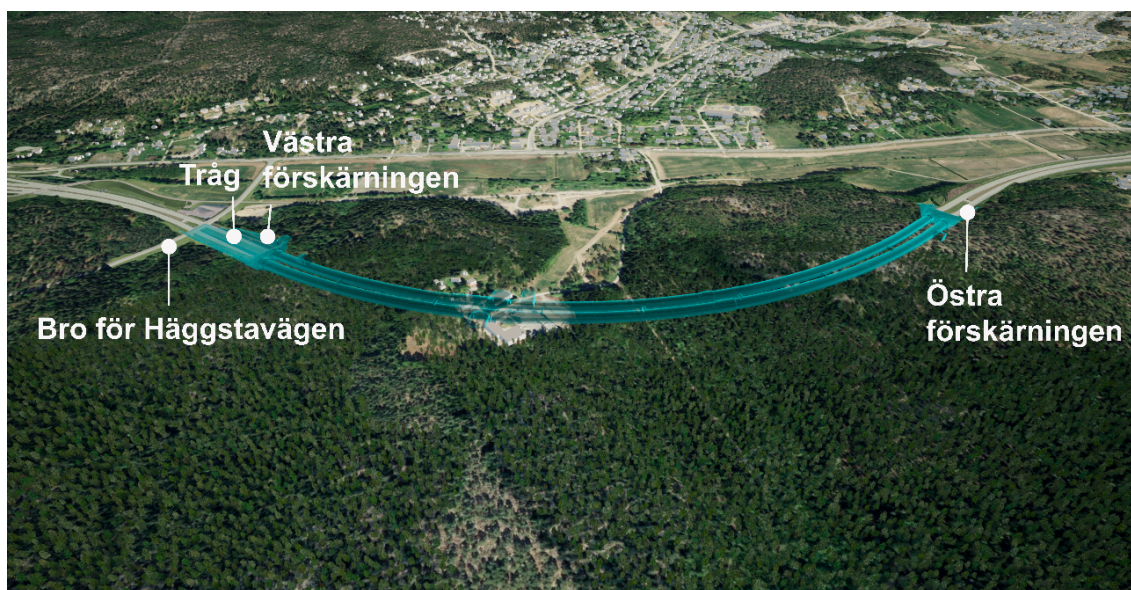
Figur 8-3. Översikt för Glömstatunneln med två parallella bergtunnlar från VR-modell. Till vänster syns Häggstavägen och tråg vid västra förskärningen och till höger bergskärning vid östra förskärningen.
