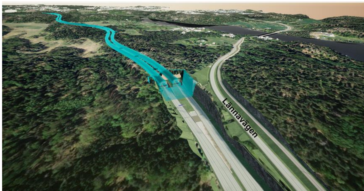
Figur 37. Flemingsbergstunnelns östra mynning och förskärning.
