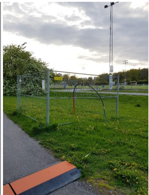
Figur 12. Höger bild. Exempel på utformning av en rörbrunn för skyddsinfiltation. Illustration från projekt E4 Förbifart Stockholm (Trafikverket, 2011). Vänster bild: Exempel på anläggning för tillfällig skyddsinfiltation. Infiltrationen sker via ett rött plaströr som installerats i marken ner till ett slutet grundvattenmagasin. Vatten tillförs via den svarta plastslangen. Foto: Anders Berzell, Trafikverket.
