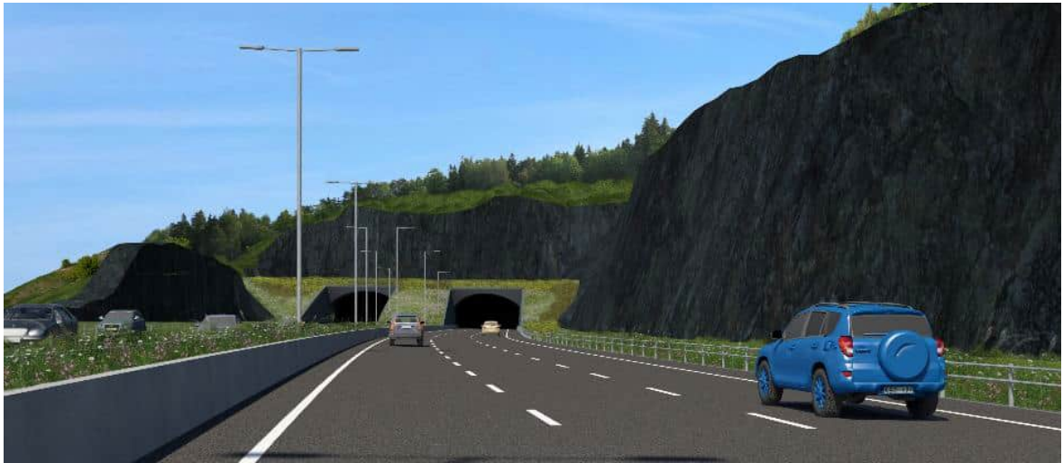
Figur 3.3 Förskärning vid Masmotunnelns sydöstra mynning.
