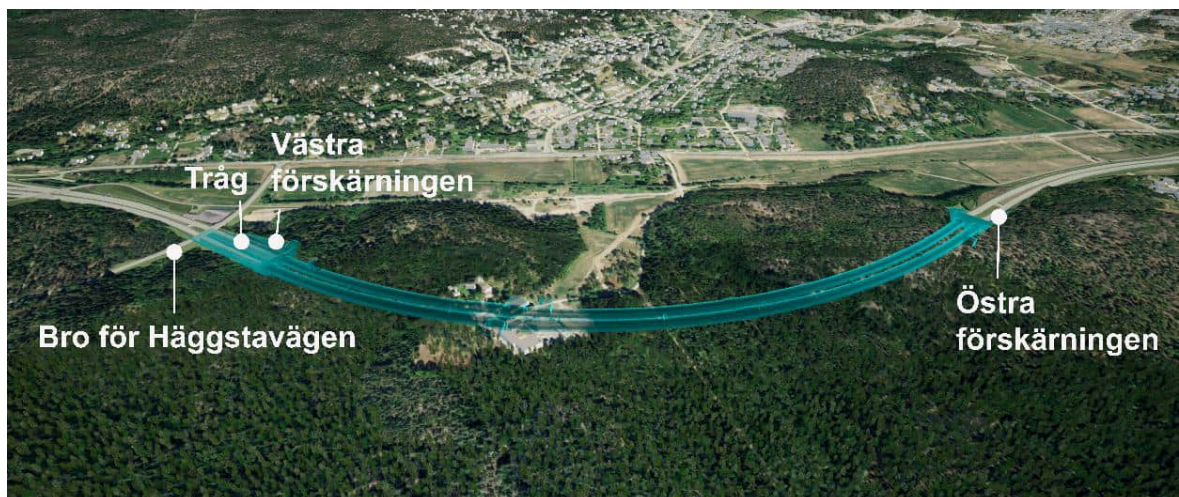
Figur 3.4 Glömstatunneln. Till vänster syns en bro för lokalvägen Häggstavägen, tråg och bergskärning vid den västra tunnelmynningen. På den östra sidan mynnar tunneln ut i en bergskärning.
