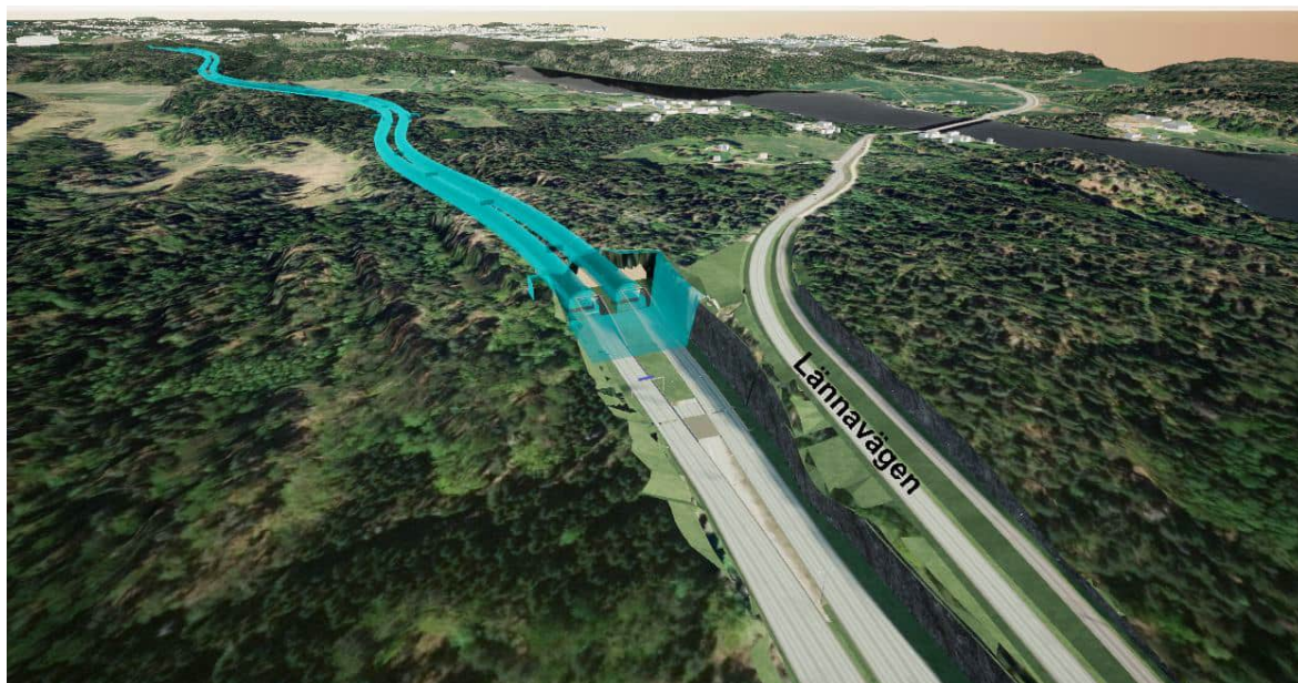
Figur 3.7 Flemingsbergstunnelns östra mynning och förskärning.
