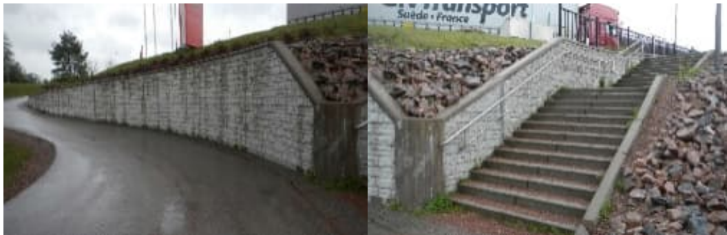
Figur 18. Visar stödmur 20-1318-2. Bilden till vänster visar vy från söder, där muren är belägen längsmed gång- och cykelvägen och bilden till höger visar vy från väster, där muren löper utmed en trapp.
