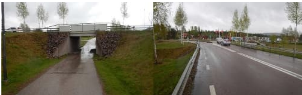
Figur 19. Visar bro 20-397-1. Bilden till vänster visar vy från norr och bilden till höger visar vy från väster.
