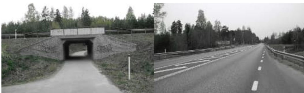
Figur 15. Visar bro 20-1079-1. Bilden till vänster visar bron i vinkel från nord och bilden till höger visar vy från öst.
