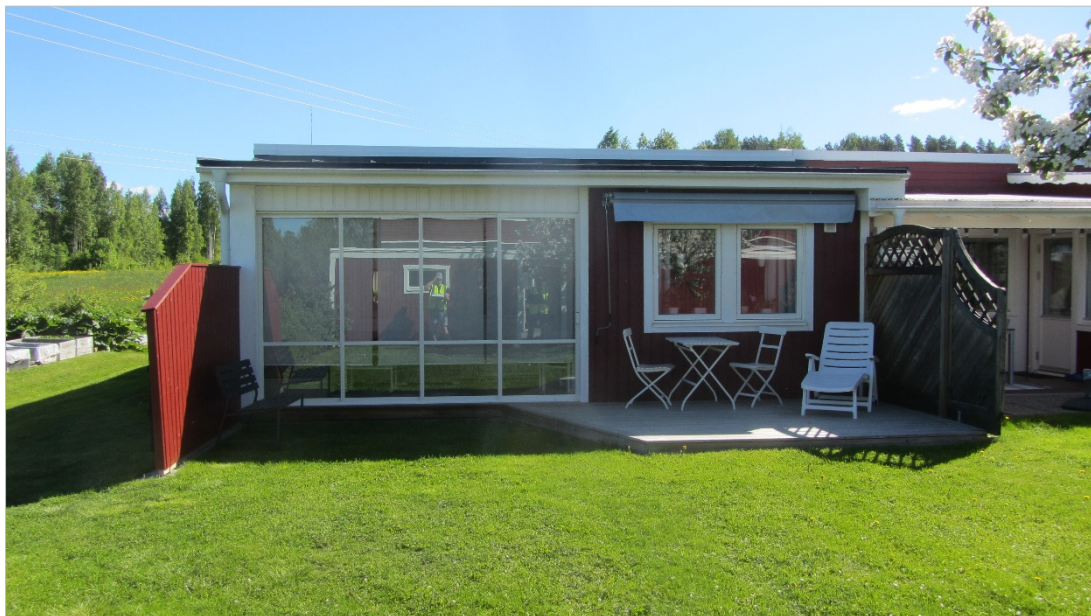
Figur 3.6: Exempel på en befintlig fastighetsnära bullerskyddsskärm.
