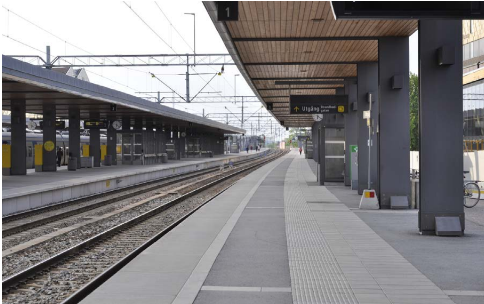
Figur 7 visar spår 1 på Uppsala Centralstation.
