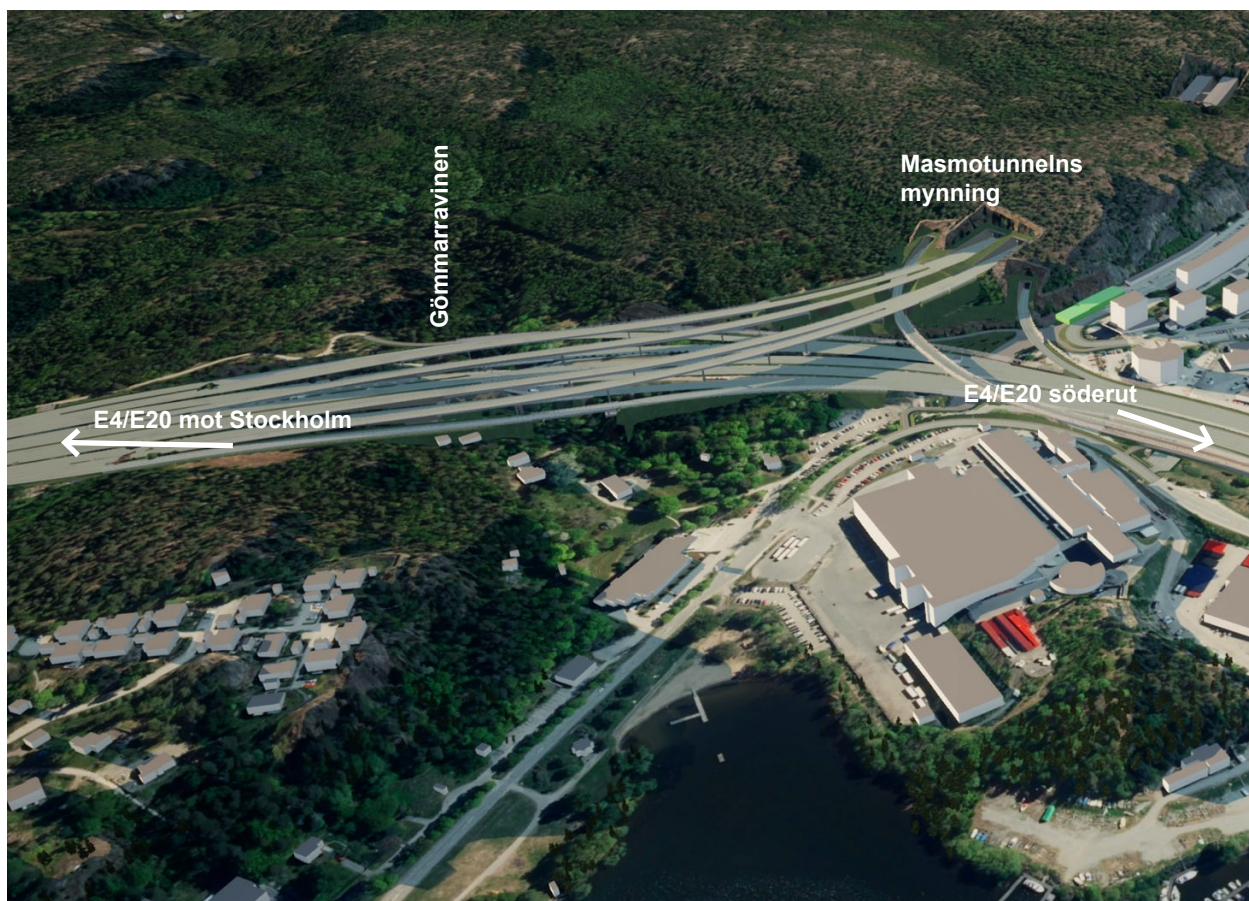
Figur 3.6 Trafikplats Gömmaren med anslutande rampbroar till E4/E20. Till höger syns Masmotunnelns mynning med fyra ingångar in i Masmoberget.
