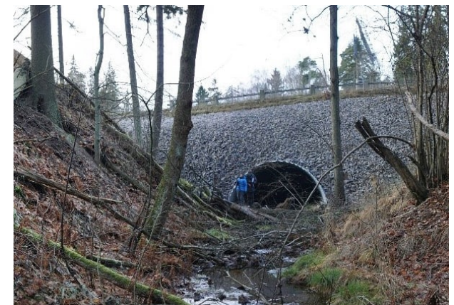
Figur 3.7 Vy mot E4/E20 vid Gömmarbäckens inlopp i trumma under vägen. I fotot till vänster syns stenmuren från 1800-talet som numera är motfylld. I fotot till höger syns motfyllnaden med stenkross och den nya valvbågen.
