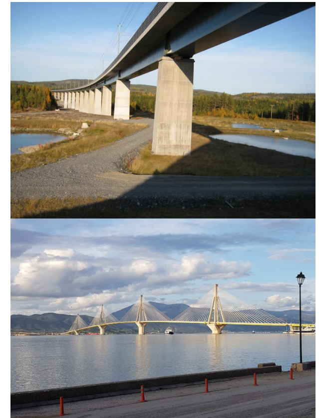
Figur 5.3 Exempelbilder på balkbro (överst) och snedkabelbro (underst).
