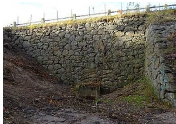
Figur 3.7 Vy mot E4/E20 vid Gömmarbäckens inlopp i trumma under vägen. I fotot till vänster syns stenmuren från 1800-talet som numera är motfylld. I fotot till höger syns motfyllnaden med stenkross och den nya valvbågen.
