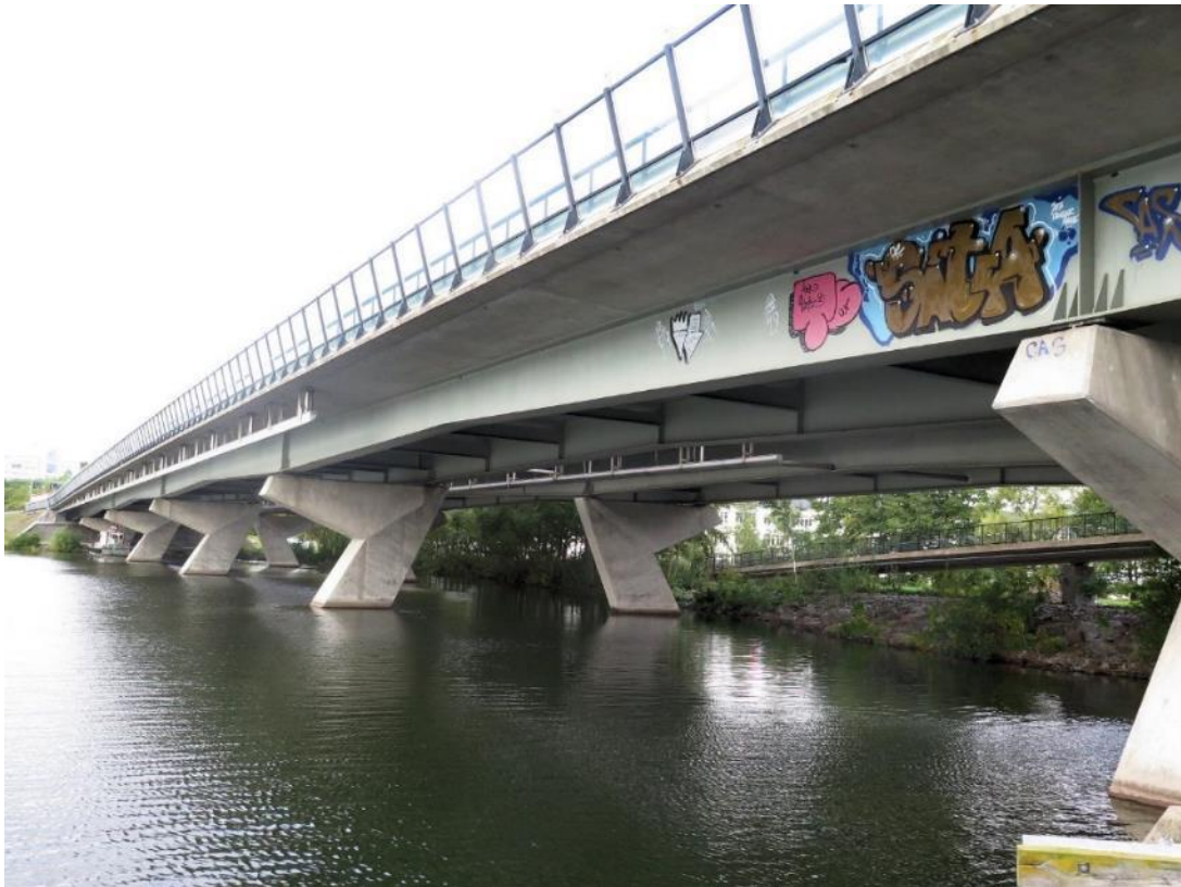
Figur 21. Befintlig vägbro över Fittjaviken med karaktäristiska Z-formade brostöd. Vy från sydost (bild från BaTMan). Gångbron skymtar mellan brostöden.
