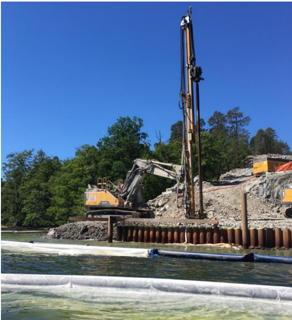
Figur 50. Arbeten för ny en ny bro över Skurusundet. Arbetsområdet avskärmas med en län med siltgardin. I strandkanten syns en spont. Foto Per Andersson.
