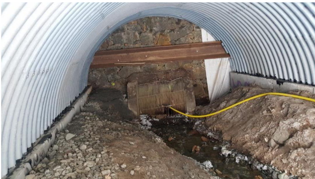
Figur 27. Vy inuti rörbron där Gömmarbäckens trumma genom vägbanken har sitt inlopp bakom ett galler. Foto Per Bergström.
