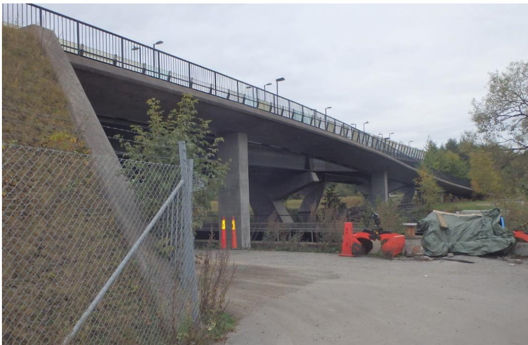
Figur 22. Gångbro över Fittjaviken, vy från nordost. De karaktäristiska Z-formade brostöden på vägbron skymtar bakom gångbron.
