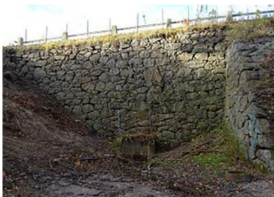
Figur 28. Vy mot befintlig väg E4/E20 östra sidan, sedan 2017 motfylld med stenkross. Denna stenmur går att se delar av inne i den valvbåge som syns på fotot ovan.
