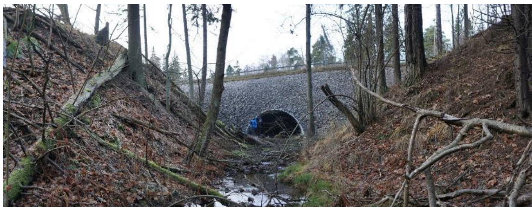
Figur 26. Vy mot befintlig väg E4/E20 östra sidan. Mitt i bild syns inloppet till den trumma som Gömmarbäcken passerar under väg E4/E20. E4/E20 går här på bank med höga stödmurar.
