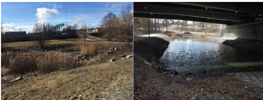
Figur 25. Dagvattenreningsanläggning öster om Vårbybron samt väster om/under Vårbybron.
