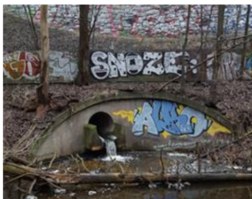
Figur 29. Utlopp från trumman och befintlig stödmur 2-1667-1, vy mot befintlig väg E4/E20 västra sidan.
