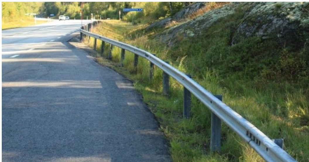
Figur 12, Exempel på sidoräcke som uppfyller gestaltningskraven, Kohlswabalk.
