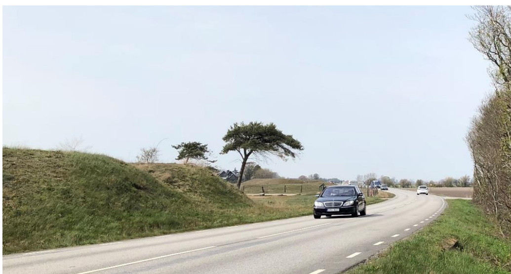
Figur 7: Skåre skansar fungerar som landmärken och är belägna nära södra sidan av väg 511.
