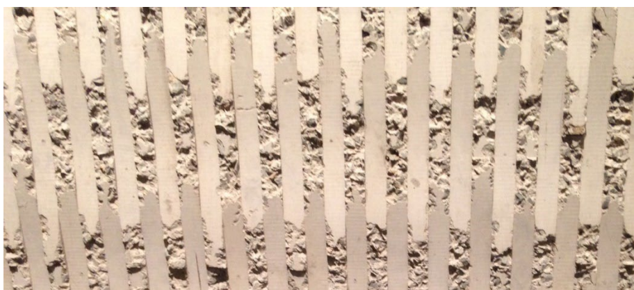
Figur 13. Exempel på mönstring av betongyta.
