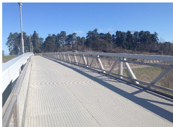
Figur 19. Exempel på Knislingebron med skyddsnät. Bilden visar gångbaneplåt med aluminium vilket föreslås för GC-bron i Lingham.
