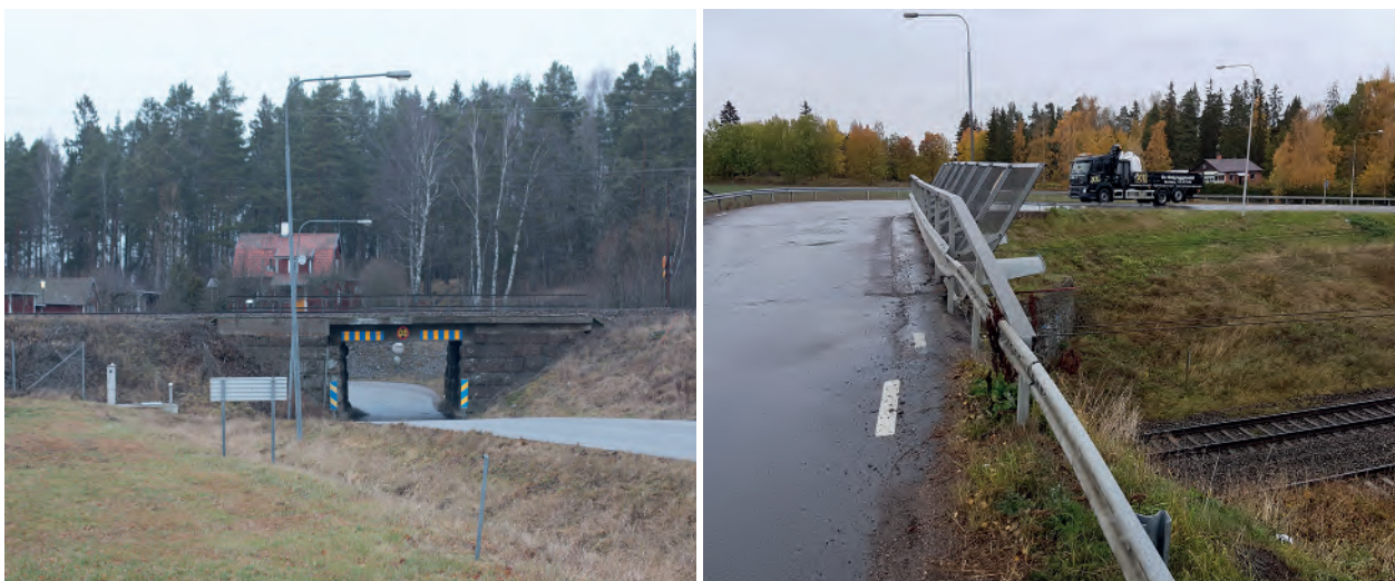
Figur 1.1. De två infarterna till Lingham från norr. Till vänster: vägporten under Södra stambanan som utgör den västra infarten. Till höger: bron över stambanan som utgör den östra infarten. Båda fotona tagna från söder om stambanan.
