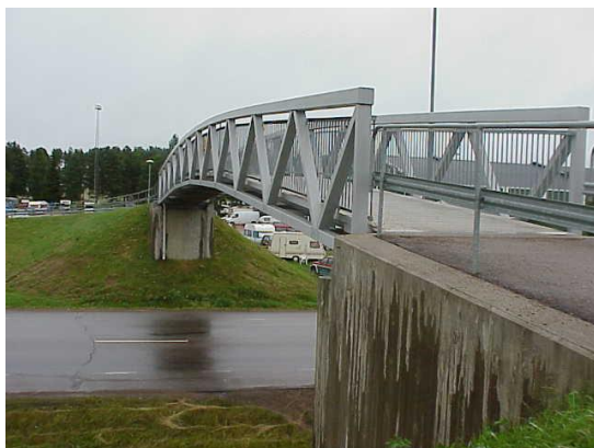
Figur 18. Exempel på Knislingebron med lutning i vertikalled och gräsklädda brokoner.
