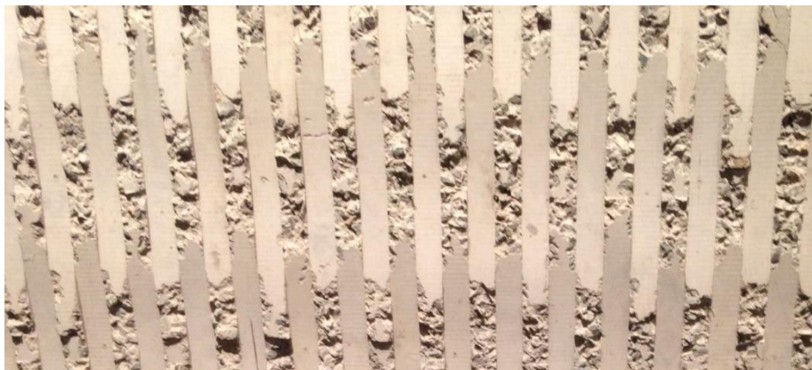
Figur 13. Exempel på mönstring av betongyta.
