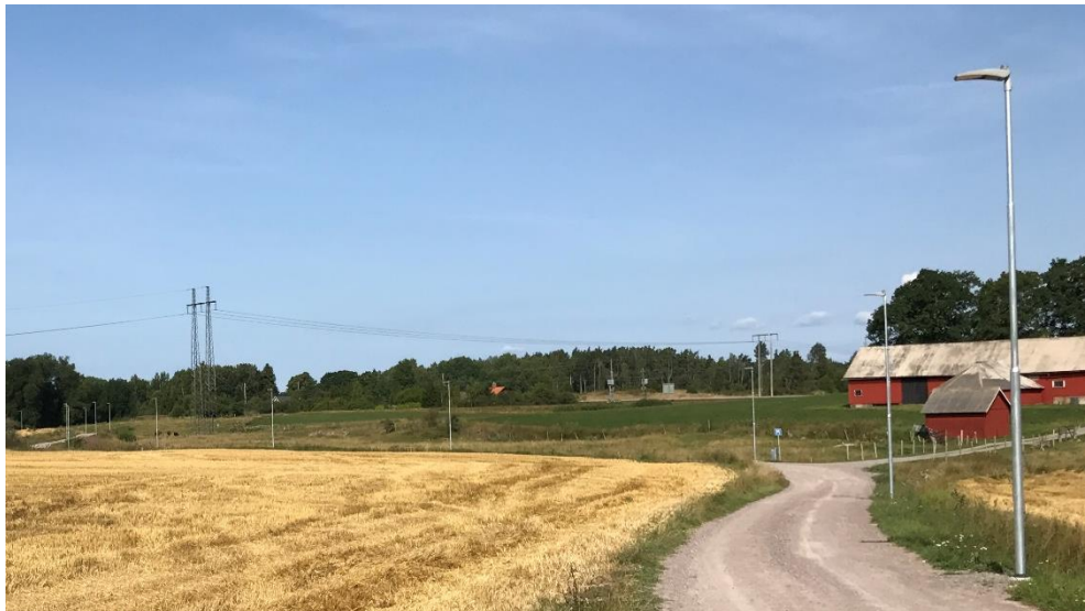
Figur 11. Befintlig belysning längs gång- och cykelvägen.
