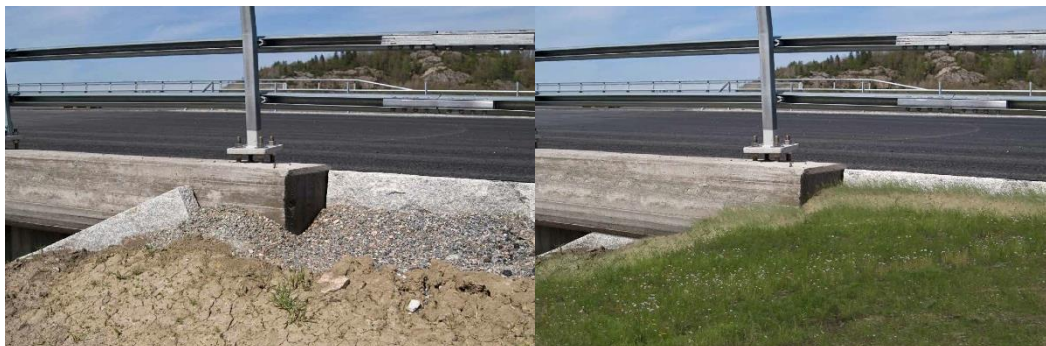
Figur 8. I bilden till vänster har omsorgen i materialmöten varit liten och ger ett ofärdigt, icke omhändertaget intryck. I bilden till höger har däremot omsorg lagts i materialmötena och resultatet blir att bron "landar" bättre i terrängen och att ytan ser färdig och omhändertagen ut. OBS! Bilden är ett exempel (foto och fotomontage från Vägbilder, Trafikverket 2011).
