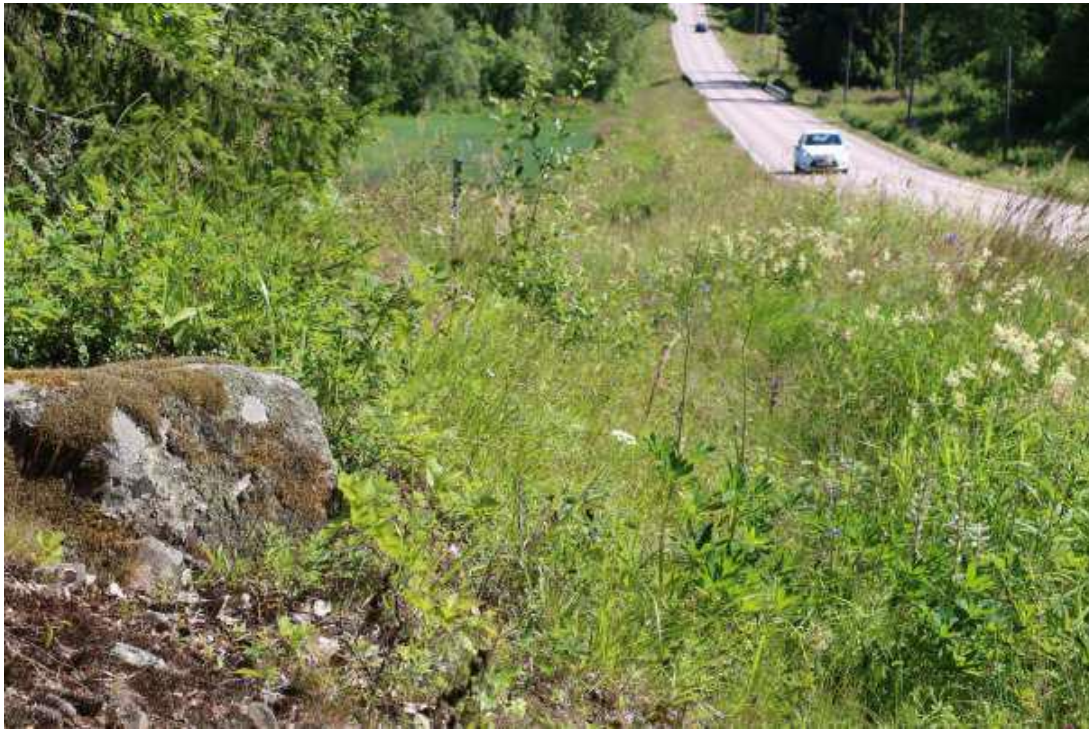
Figur 10. Artrik väggkant från Visteberg utanför Karlstad.
