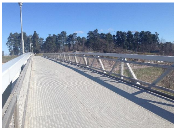
Figur 19. Exempel på Knislingebron med skyddsnät. Bilden visar gångbaneplåt med aluminium vilket ej föreslås för GC-bron i Lingham.
