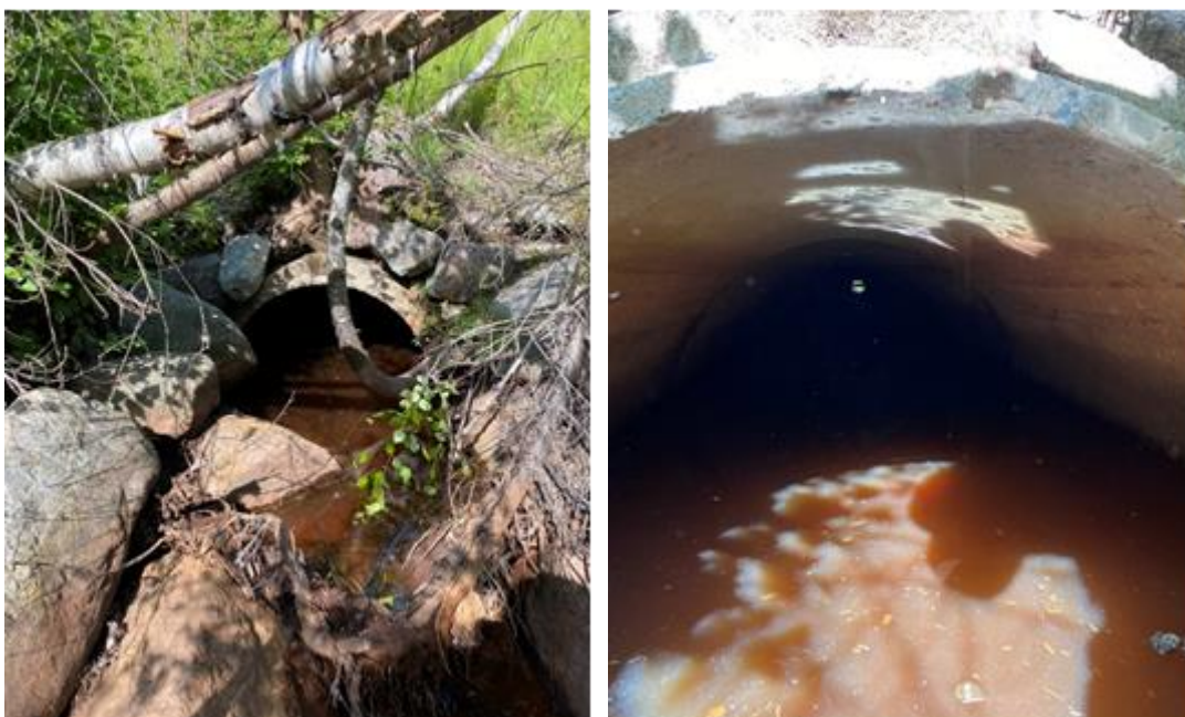
Figur 4.5-13 och Figur 4.5-14. Hackgärdsbäcken, inlopp på västra sidan av E4. Se även Figur 4.5-17.
