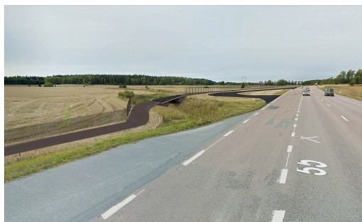
Nya broar över vattendrag som i bild utförs med plattrambroar
