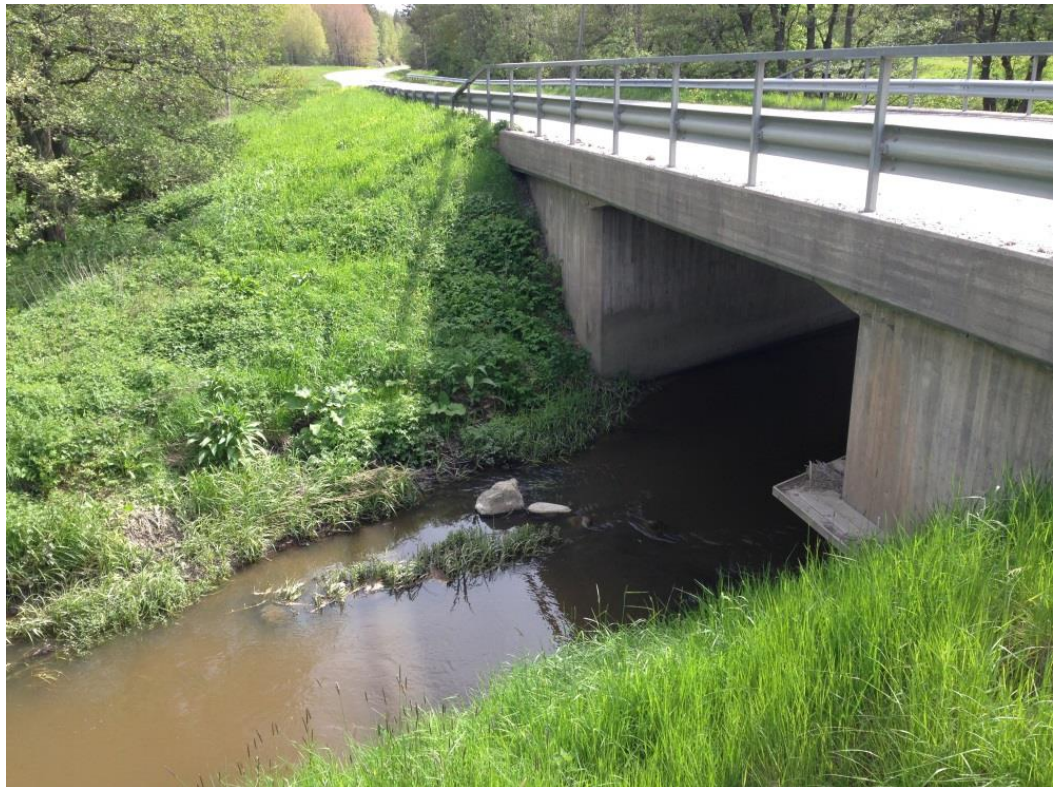
Figur 19. Södra passagen över Vitsån. Utterpassagen skymtar ovan vattenytan vid brostödet närmast i bild..
