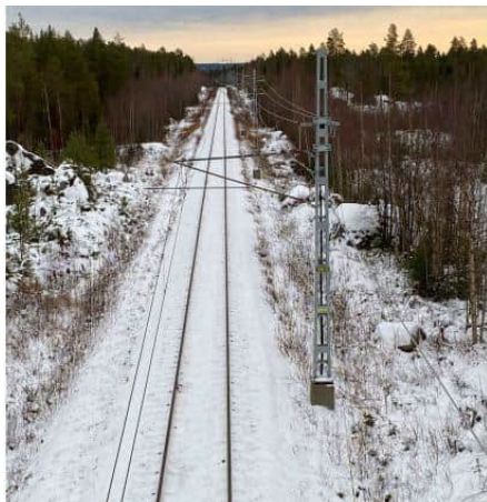
Figur 2. Bild norrut på del av Haparandabanan som är ostängslad vid kilometer 28+000 i riktning norrut.
