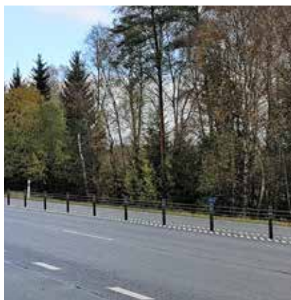
Figur 47. Nytt mitträcke ska om möjligt vara ett vajerräcke likt befintliga räcken i projektets närhet.
