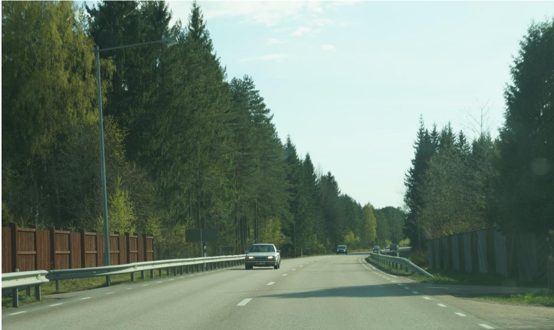
Figur 8. Några av bostadshusen i Lyckan har bullerskyddsplank ut mot väg 62.
