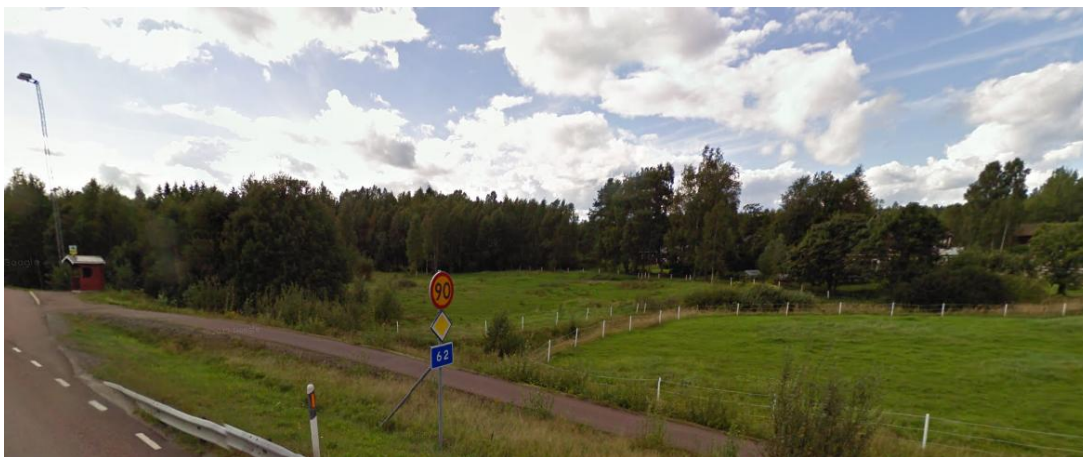
Figur 15. Det öppna diket vid Grossbolstorp. Diket kommer att påverkas av en ny påfartsväg.
