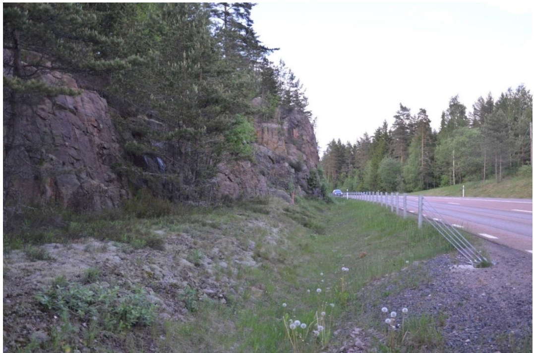
Figur 22. Bergsskärning strax norr om Grossbolstorp.
