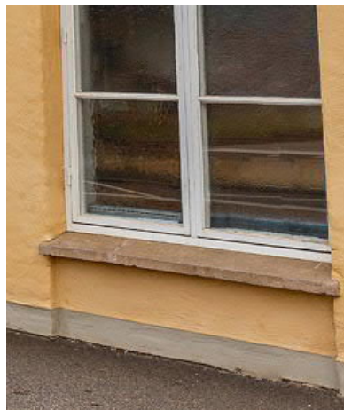
Figur 25 Kalksten i underkant fönster.
