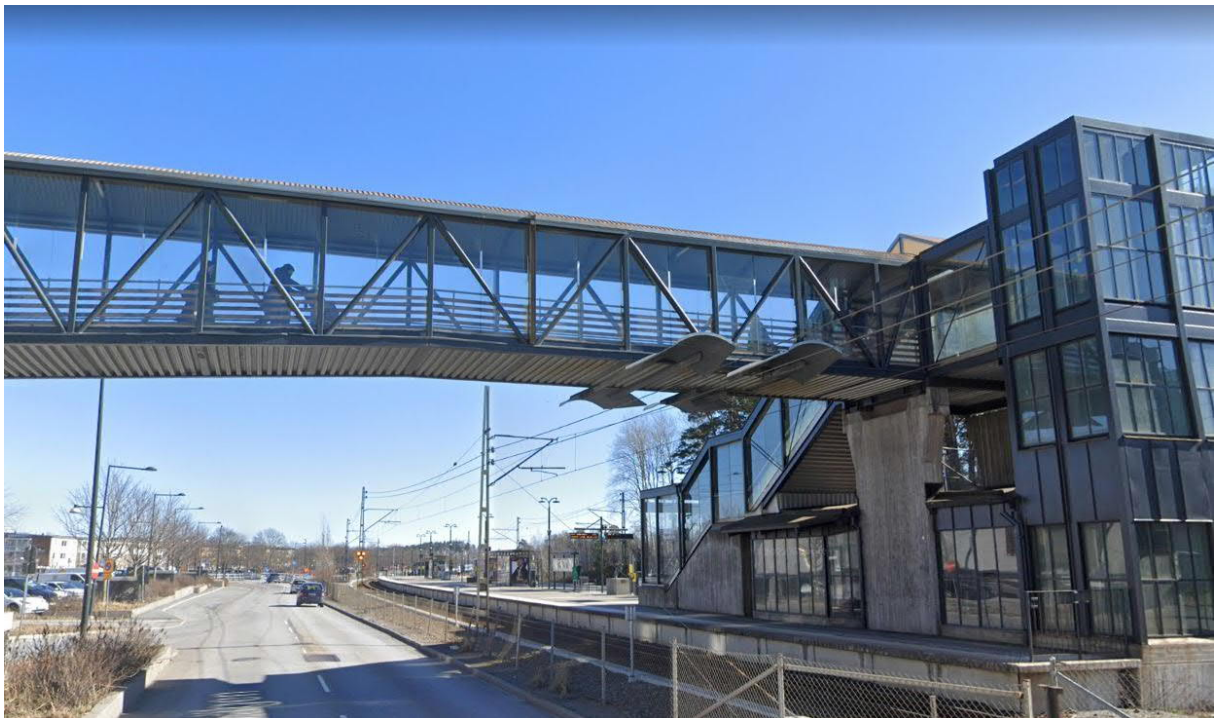
Figur 12. Referensexempel, gångbro av fackverkstyp över Stora Marknadsvägen vid Roslagsbanans Täby station.
