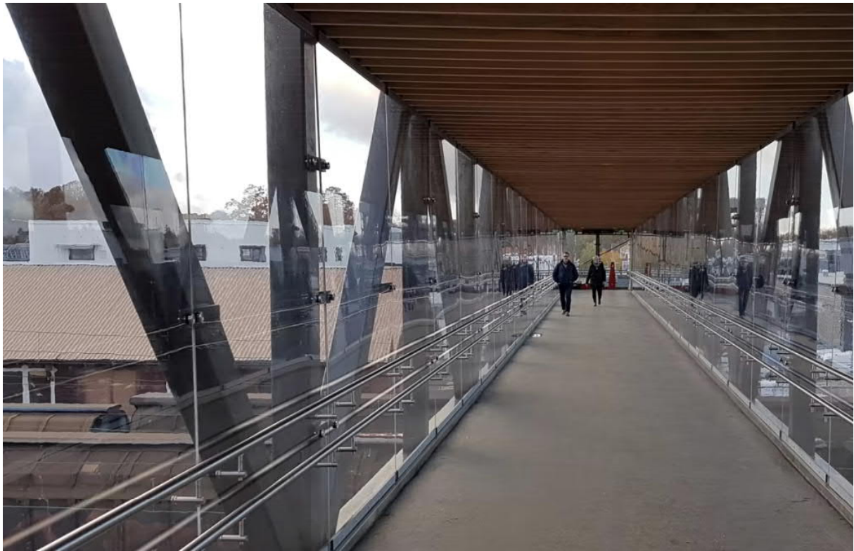
Figur 13. Referensexempel, gångbro Älmhult station. Här är glaset placerat på insidan om fackverket vilket underlättar om det behöver göras åtgärder på glaset.
