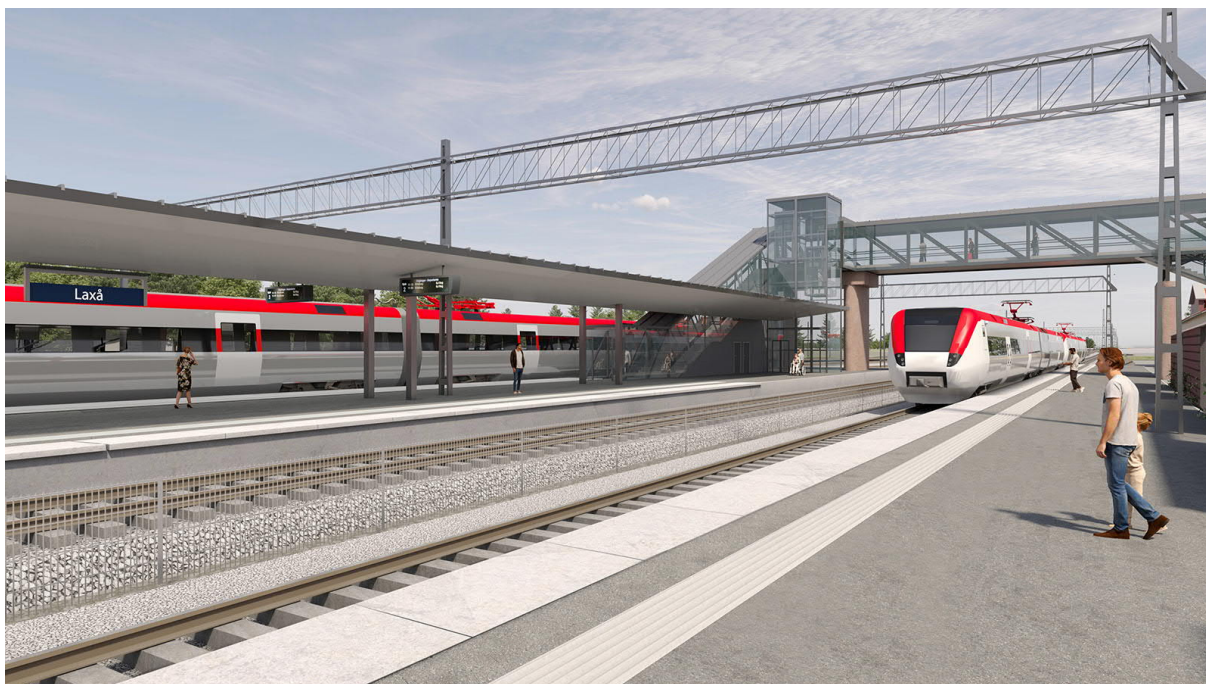
Figur 16. Plattform, vy mot plattformstaken och gångbron.
