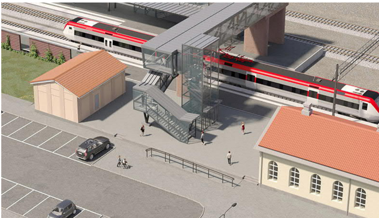
Figur 22. Stationshusets gula puts, teknikhusets orangerosa fasad och de faluröda skivstöden.
