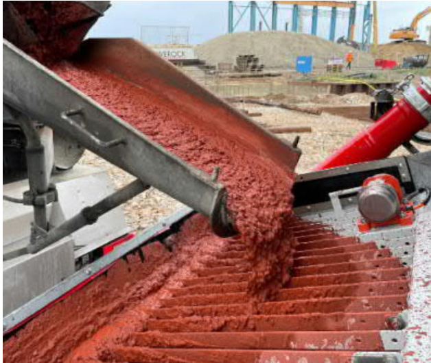
Figur 20 Gjutning med infärgad betong
