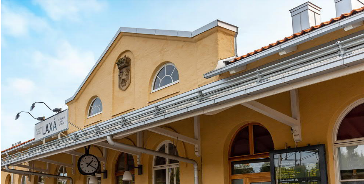
Figur 23. Stationshuset från plattformssidan med fina plåtarbeten.
