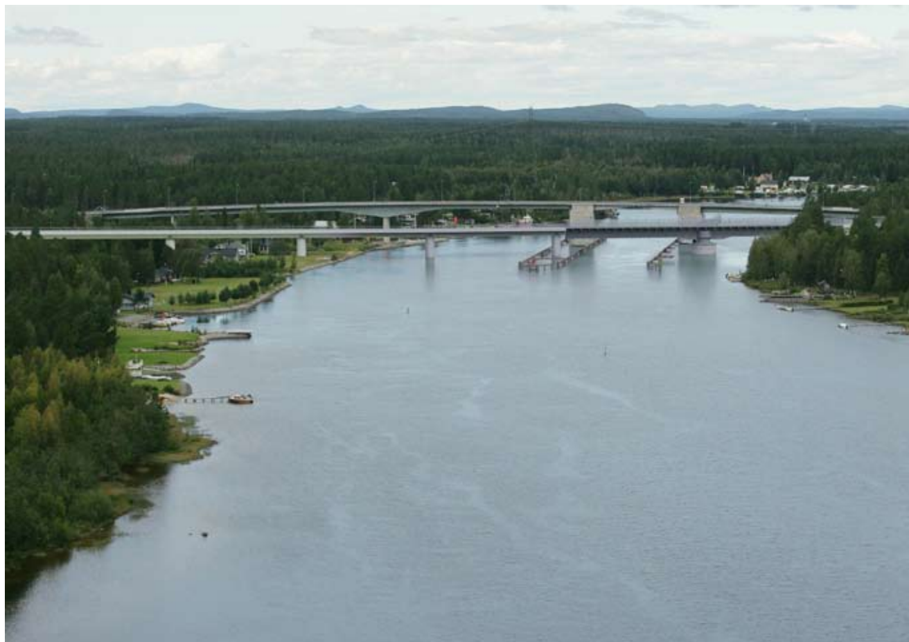
Figur 2.2:2 Fotomontage av järnvägsbro med segelfrihöjd på cirka 8 meter över Pite älven i Pitsund framtagna av Berg AB.
