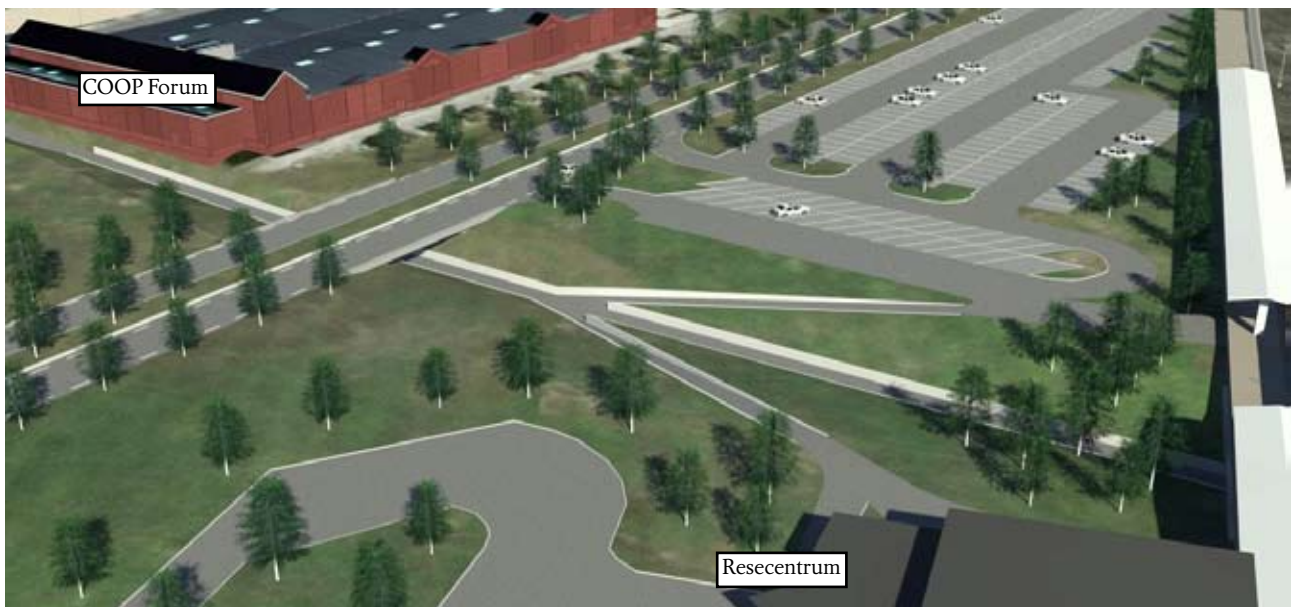
Figur 2.5:4 Vy gång- och cykelpassage under Timmerleden mellan COOP och resecentrum. Denna gång- och cykelväg går in mot resecentrum och skulle kunna användas in under järnvägen för att skapa kontakten med den mellanliggande plattformen.
