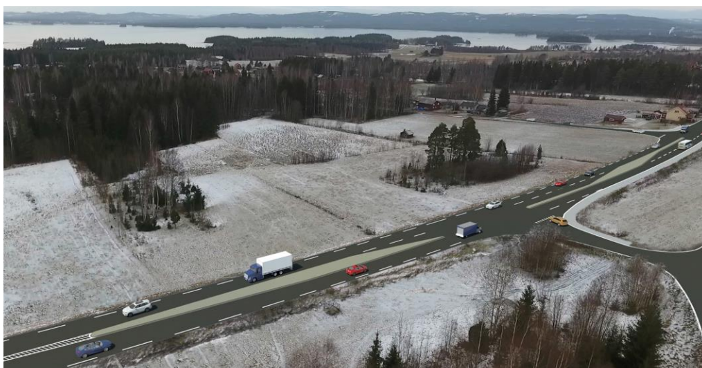
Figur 8. Där delsträcka 1 ansluter till befintlig väg genom Holen föreslås refuger för att dämpa hastigheten och öka säkerheten i korsningar.
