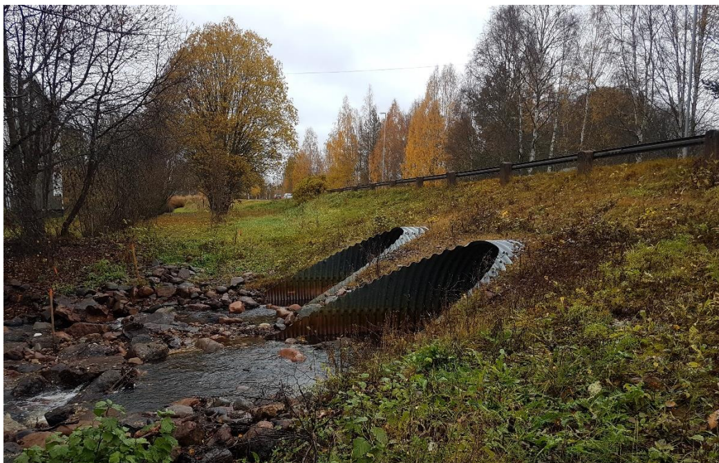
Figur 38. Enån korsar E45 genom två rörbroar strax söder om Trunna.
