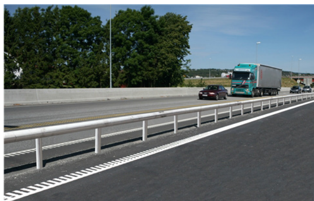
Exempel på ett mitträcke i rundad stålbeamtstyp. Foto: Vik Ørsta
