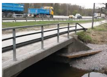
Bild 4.2.5:3 Exempel småviltspassage i rörbro
