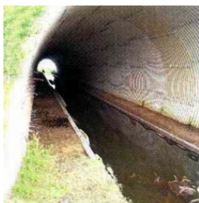
Bild 4.2:3 Exempel småviltspassage i rörbro
