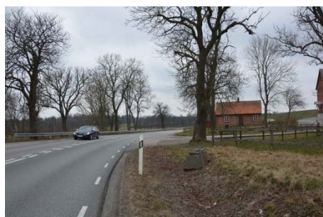
Figur 5.2.1:5 Befintlig väg genom Assmåsa
