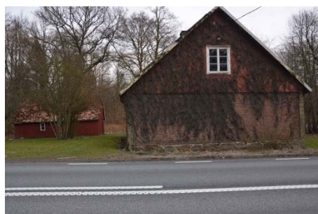
Figur 5.2.1:6 Bostadshus nära befintlig väg
