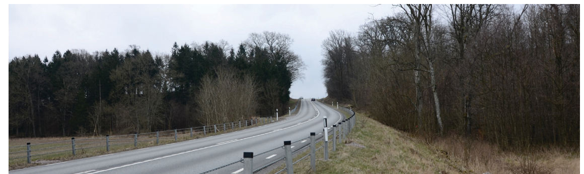
Rasbranten idag, sett nedifrån, mot sydost.
