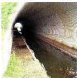
Bild 4.2.4:2 Exempel småviltspassage i rörbro
