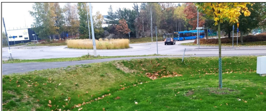
Exempel på svackdike. Från dagvattenutredningen
