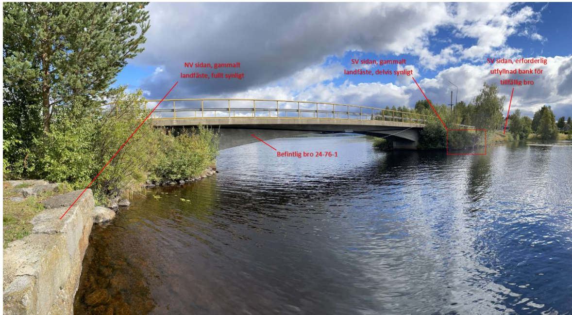
Figur 11. Översiktsbild av västra sidan av befintlig bro där tillfällig bro föreslås anläggas.
