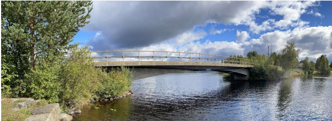
Figur 5. Den befintliga bron har en diskret utformning och smälter väl in i det omgivande landskapet. Foto: Norconsult AB.
