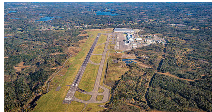
Figur 91. Flygfoto över Landvetter flygplats, vy mot nordost. Flygplatsen utgör ett bebyggelseområde där den storskaliga infrastrukturen dominerar och skapar en stark kontrast till omkringliggande skogsområden. (Foto: Per Pixel, 2020)
