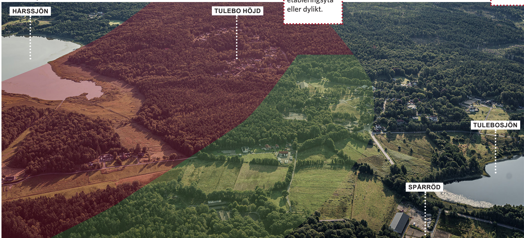
Figur 79. Flygfoto över fokusområdet Tulebo med korridorsalternativ illustrerat i bild, vy mot öster. Den röda färgen illustrerar bergtunnel och den gröna färgen illustrerar anläggning i markplan. I bilden syns Hårssjön till vänster och Tulebosjön till höger. Mellan sjöarna finns jordbrukslandskap och bostadsbebyggelse. (Foto: Per Pixel, 2020)
