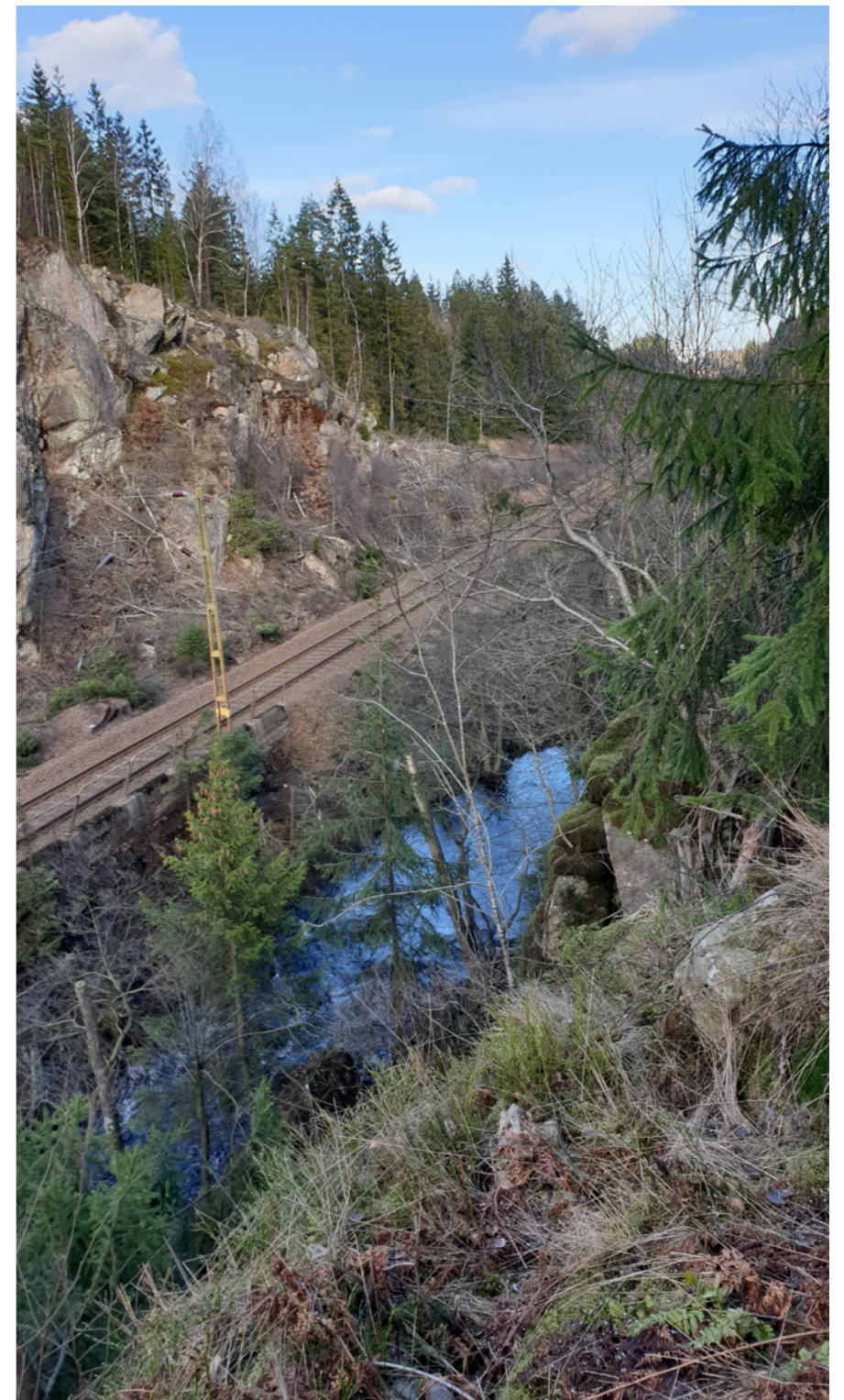
Figur 6.14 Foto över sprickdalen vid Risbohult. På bilden syns Kust till Kustbanan och Mölndalsån.
